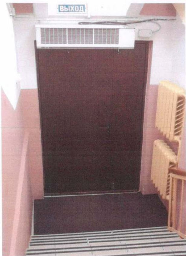
Фото №25. Лестница, пути эвакуации,
