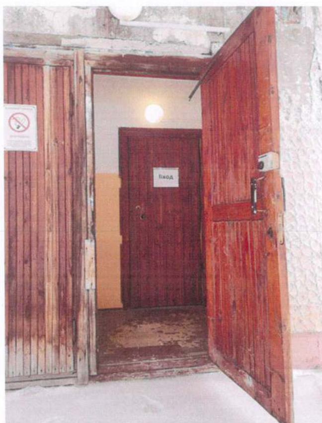
Фото №10. Дверь (входная) №2, тамбур
