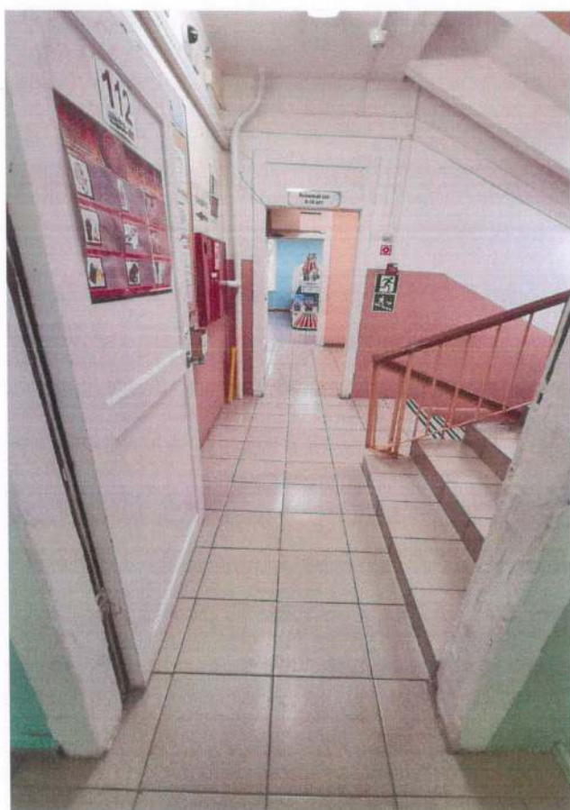
Фото №11. Коридор, пути эвакуации
