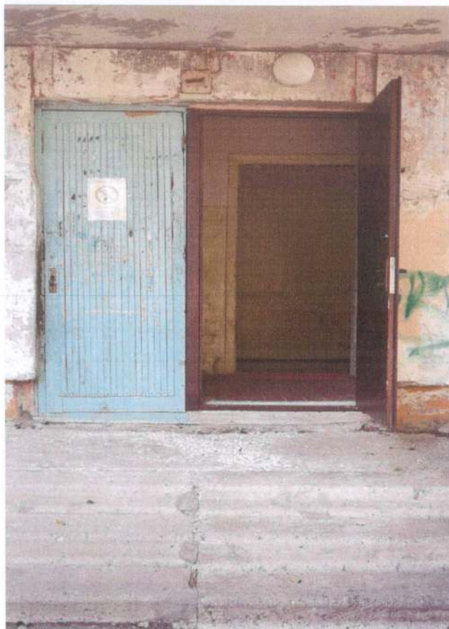
Фото №37. Дверь эвакуационного выхода, тамбур, пути эвакуации
