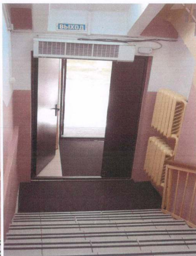
Фото №26. Лестница, пути эвакуации
