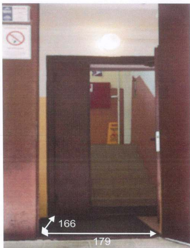
Фото №9. Дверь (входная) №1, тамбур
