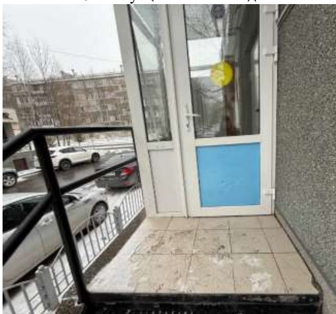
ФОТО № 28 Эвакуационный выход
