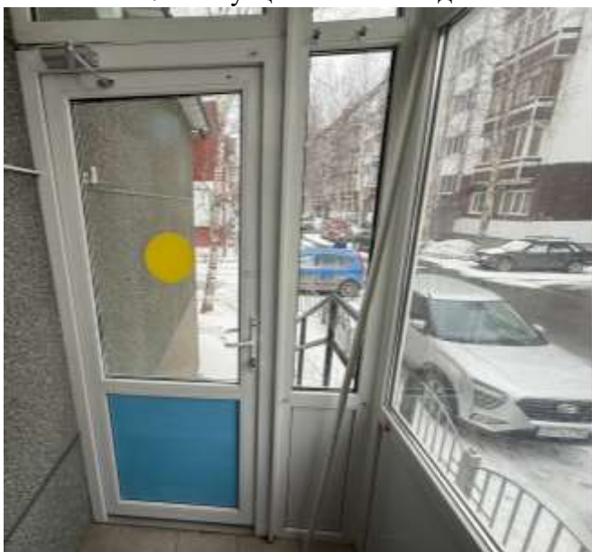
ФОТО № 27 Эвакуационный выход
