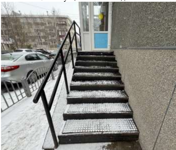
ФОТО № 29 Эвакуационный выход
