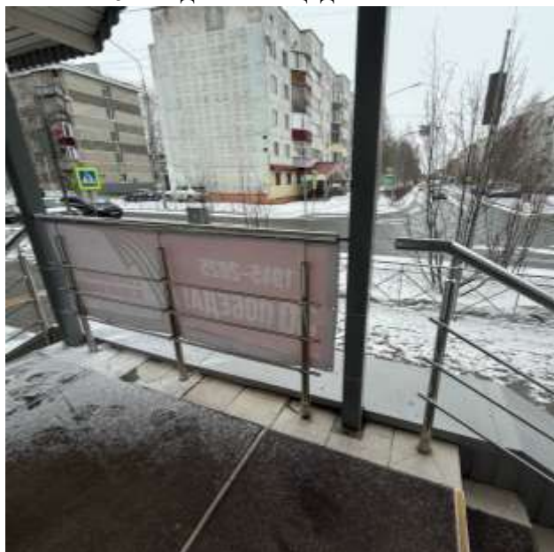
ФОТО № 6 Входная площадка
