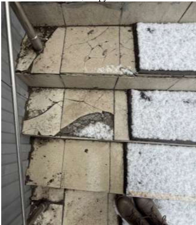
ФОТО № 3 Лестница наружная
