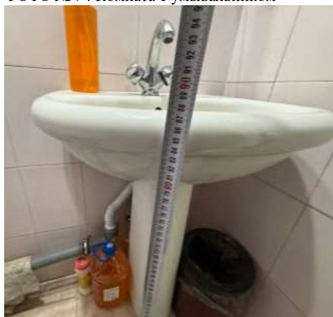
ФОТО № 74 Комната с умывальником
