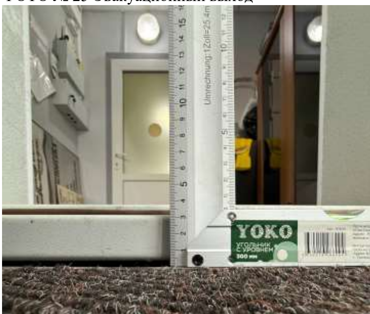
ФОТО № 25 Эвакуационный выход
