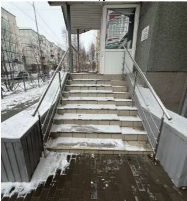
ФОТО № 1 Лестница наружная
