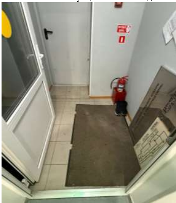
ФОТО № 23 Эвакуационный выход
