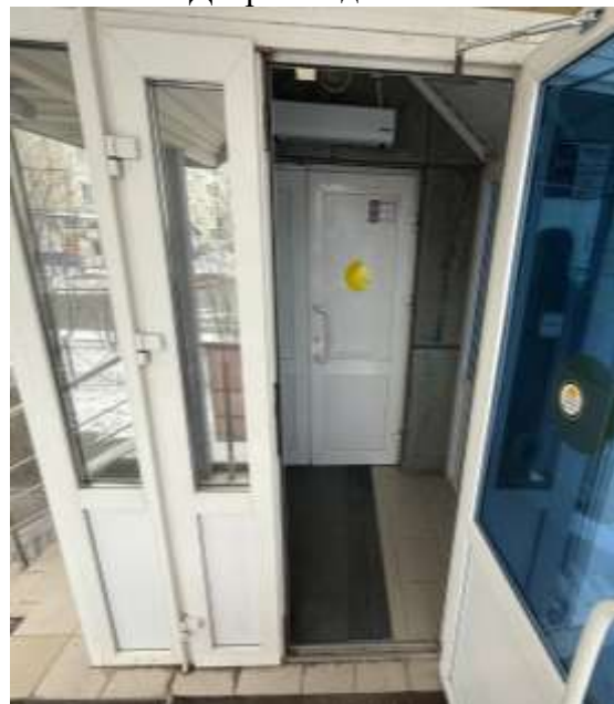
ФОТО № 8 Дверь входная
